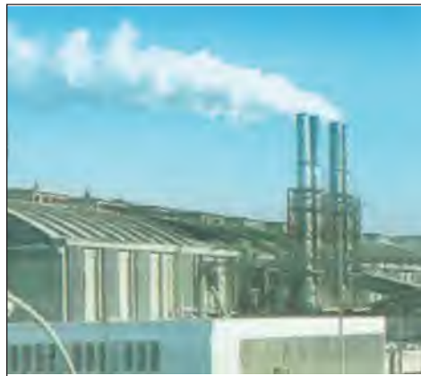
8. Usine de traitement de phosphate
